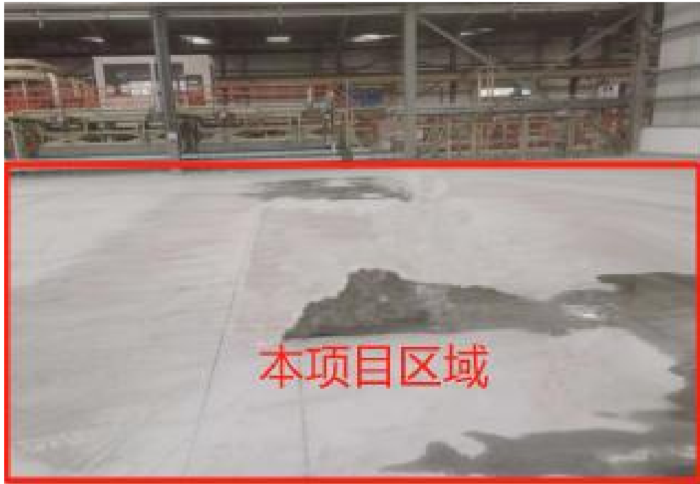
图2-5 本项目租赁厂房现场照片
