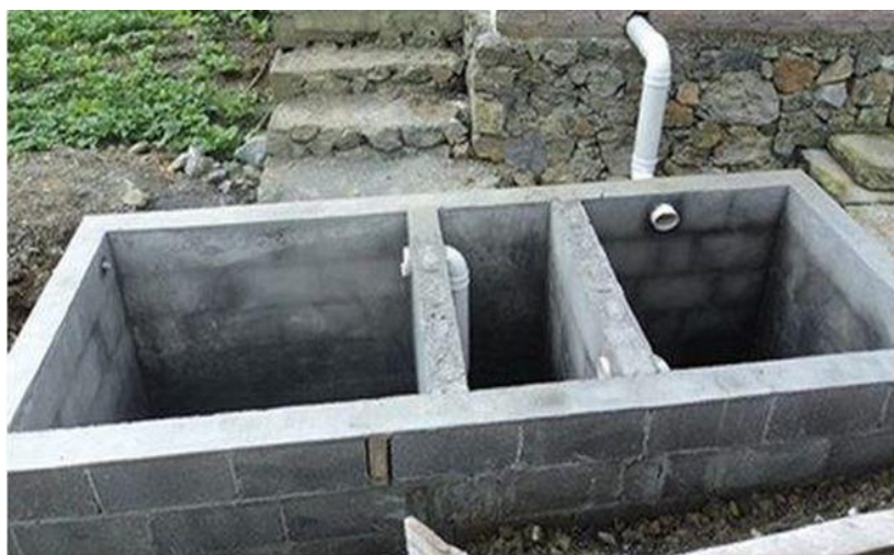
图 4-2 砖砌三格化粪池示意图
